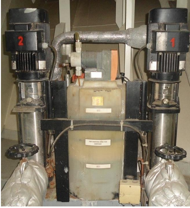
Kazan Besleme Suyu Pompalarına Bağlı Bulunan Dozaj Ünitesi
