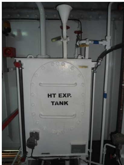
Bir Expansion Tank ve Üzerinde Yer Alan Kimyasal Çekirme Bölümü
