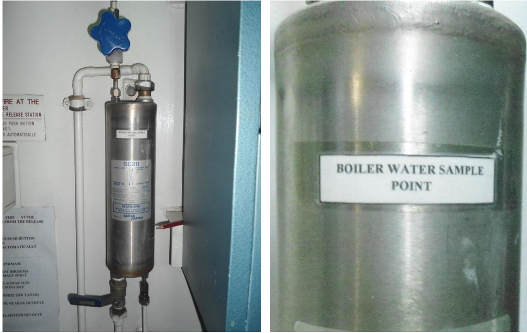
Kazan Suyu için Numune Alım Noktası
