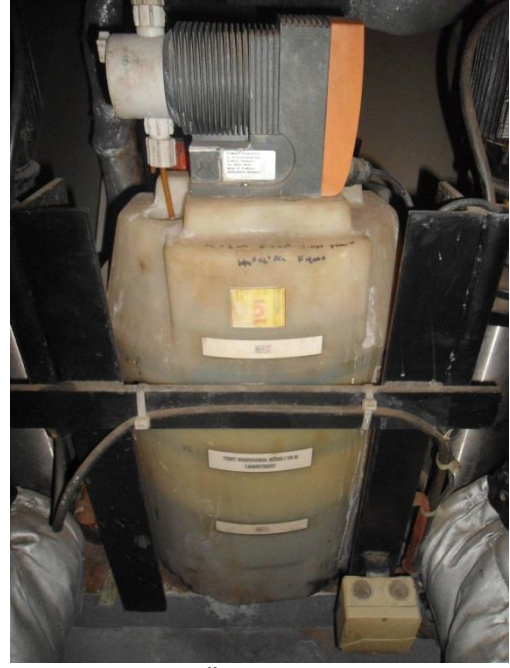
Kazan Besleme Suyu Pompalarına Bağlı Bulunan Dozaj Ünitesi
