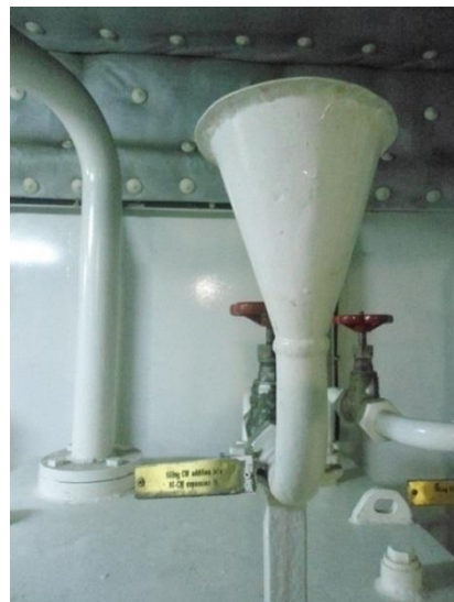
Bir Expansion Tank ve Üzerinde Yer Alan Kimyasal Çekirme Bölümü
